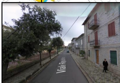
Tipologia edilizia in area di espansione fino agli anni 50. Via Repubblica
